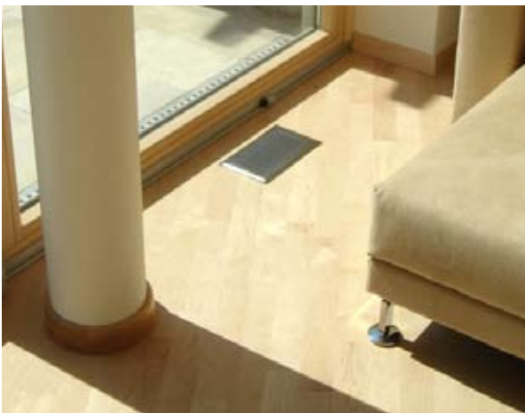
Zuluftöffnung im Boden
